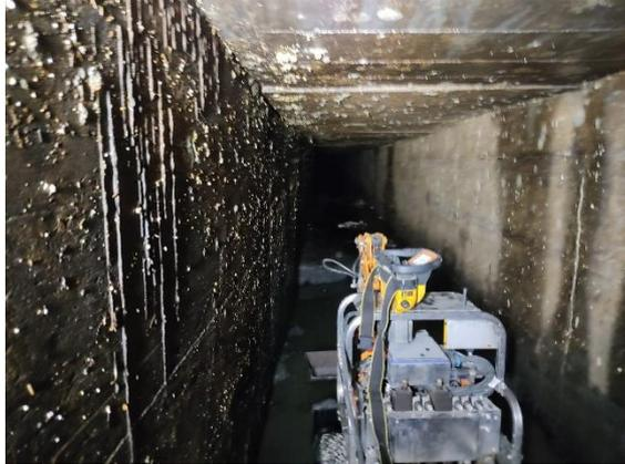
**Figura 3. Il digger radiocomandato all'interno della botte a sifone**
